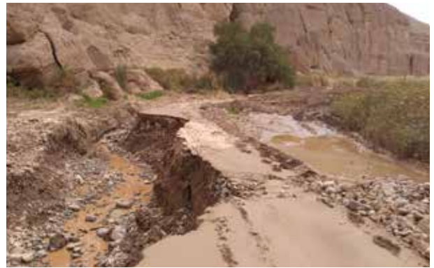
Camino a Huatacondo destruido. Tamentica.
