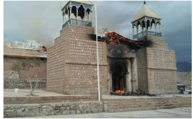
Incendio Iglesia de Mamiña. Coordinación equipos de trabajo y emergencias.
