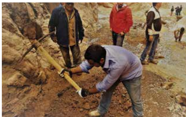
Trabajos de despeje de camino bloqueado en “Garganta del Diablo”, Huatacondo
