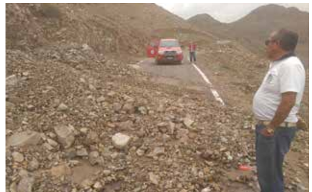
Deslizamiento de material en ladera de cerro destruyendo camino y bloqueando localidad de Macaya.
