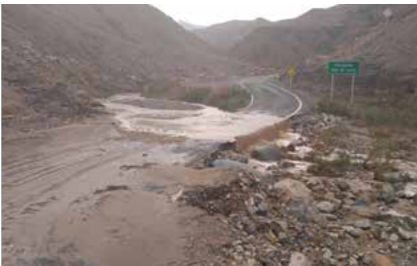
Preciso momento en que se produce bajada de agua destruyendo camino y bloqueando localidad de Macaya.
